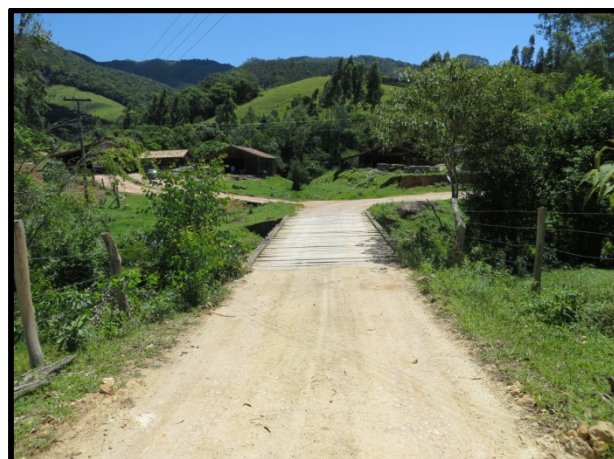
Ponte Rio Tefália–Sinalização e Guarda-corpo
