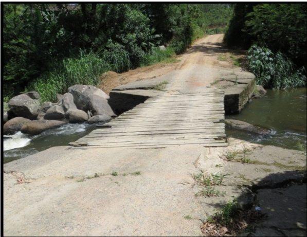
Ponte sobre Rio Capivari existente
