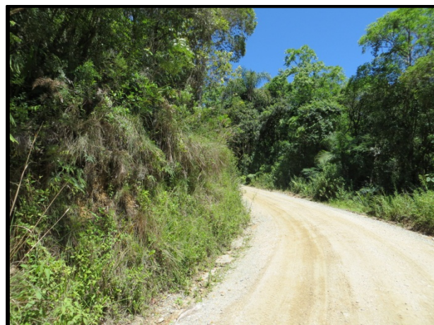
Retificação de curva acentuada a esquerda
