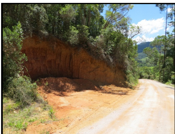
Reconformação de Talude escavado
