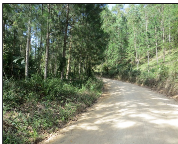
Talude com eucalipto
