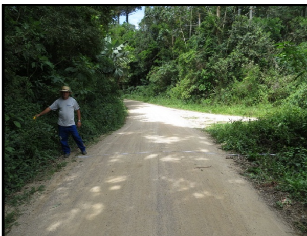
Retificação de curva acentuada a esquerda
