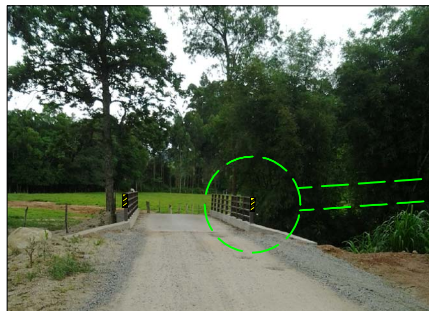
POSIÇÃO: 0+161 (LE/LD) E 0+173 m (LE/LD) PLACA DE SINALIZAÇÃO DE BORDO DE PONTE
